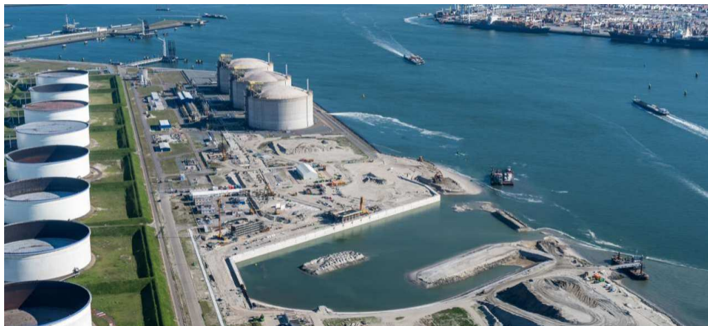
Figuur 12: Luchtfoto van de aanleg van de LNG Breakbulk Terminal (Smiet).
