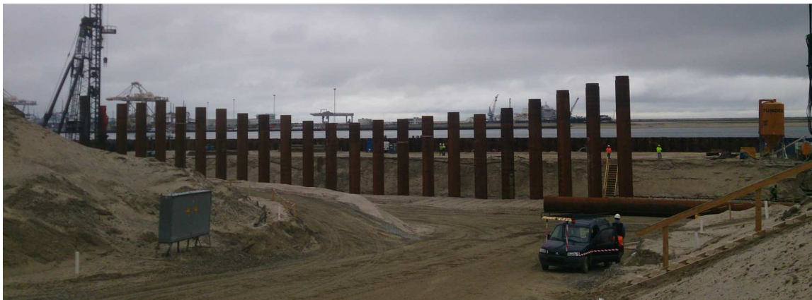
Figuur 2: Realisatie kademuur van de SIF-terminal, te Rotterdam (Frolke).
