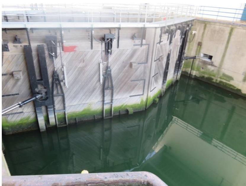
Figuur 5 Sluisdeuren Goereese Sluis
