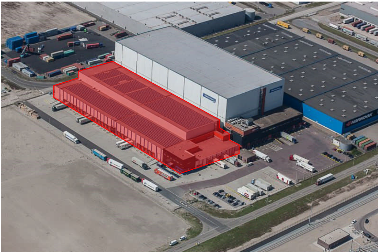
Figuur 12. Het gebouw van Kloosterboer (Maasvlakte), met rood gearceerd gebouwdeel B.
